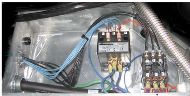
Компоненты блока механических контакторов. Вид слева и справа.
